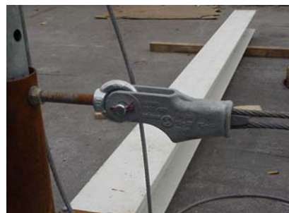
Bild 4: Seitenschutz aus straff gespannten Stahlseilen
