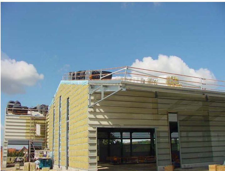
Bild 11: Montierte Wandelemente inkl. Flachdachsicherung (kein Umbau notwendig)
