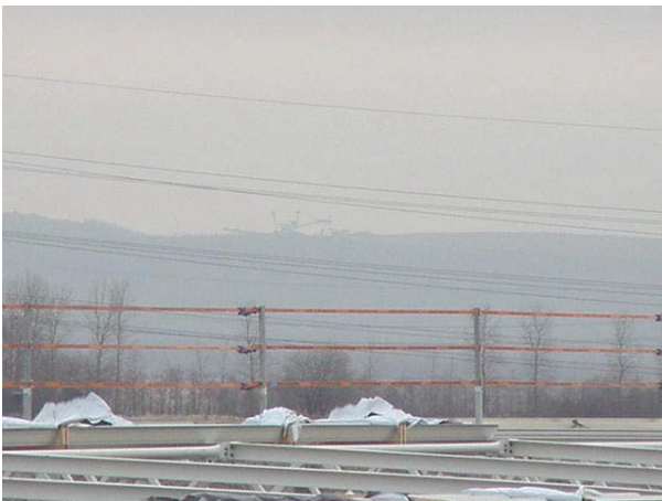
Bild 6: Stahlskelettkonstruktion mit Flachdachsicherung
