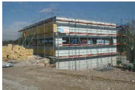
Bild 2: Beispiel einer eingerüsteten Hallenkonstruktion mit abgestütztem Fassadengerüst
