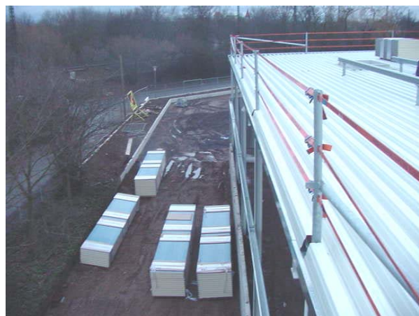
Bild 7: Montiertes Profilblech mit Flachdachsicherung
