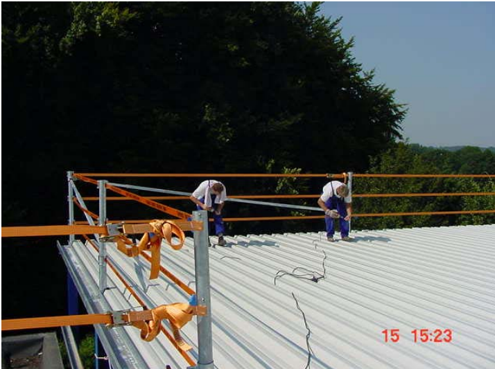
Bild 12: Sicherung des Dachrandes bei Profilblech-Verlegearbeiten
