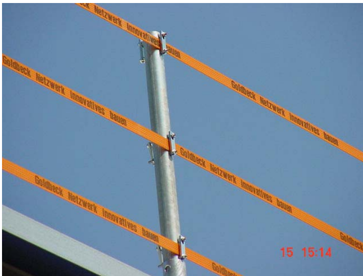
Bild 9: Zurrgurt mit Spannelement, ABS-Ratsche inkl. TFI
