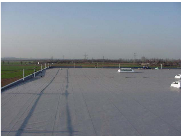
Bild 8: Aufgebrachte Dachhaut mit Flachdachsicherung
