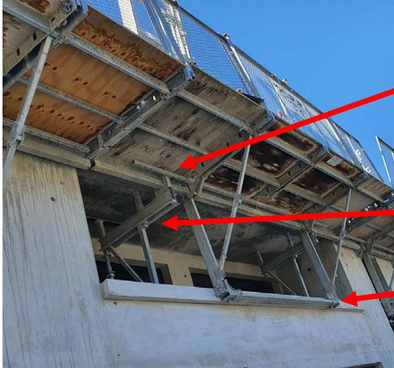
Dispositif de verrouillage (Barre anti soulèvement)
