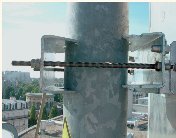
Support inférieur d'antenne. Réglage du tilt par action sur les fixations hautes et basses de l'antenne.
