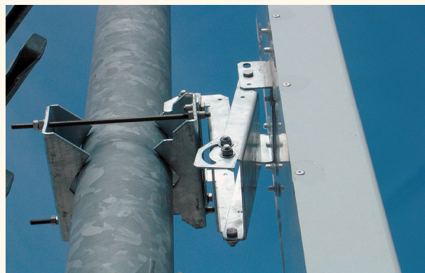
Support supérieur d'antenne Réglage de l'azimut par action sur la fixation haute de l'antenne.
