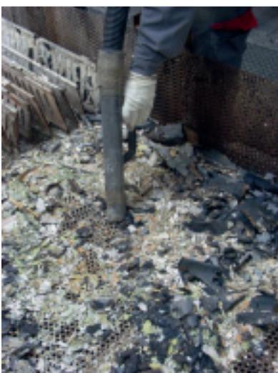
Sortie du chariot après craquelage thermique et nettoyage avec un aspirateur à filtre à très haute efficacité (THE).
