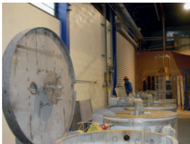
Décapage chimique : cuve avec couvercle et aspiration.
