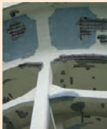
CHUTE DE BÉTON
