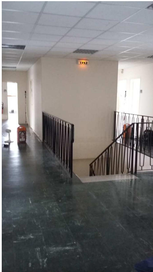
Figure 3 : Site 1 - Bâtiment C - Palier et circulations avec DVA vertes en bon état
