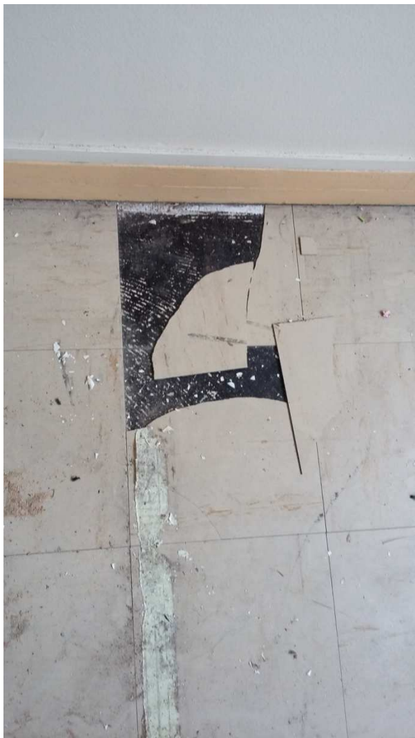
Figure 1 : Site 1- Bâtiment J – Bureau avec DVA beiges dégradées
